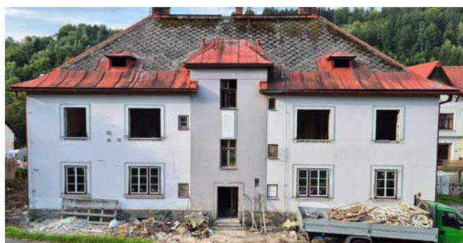
V přízemí jsou již nová okna, v patře se zatím větrá.
