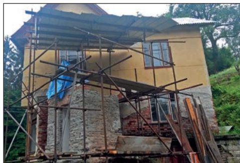
Rekonstrukce kaple v roce 2016 byla skutečně důkladná.
