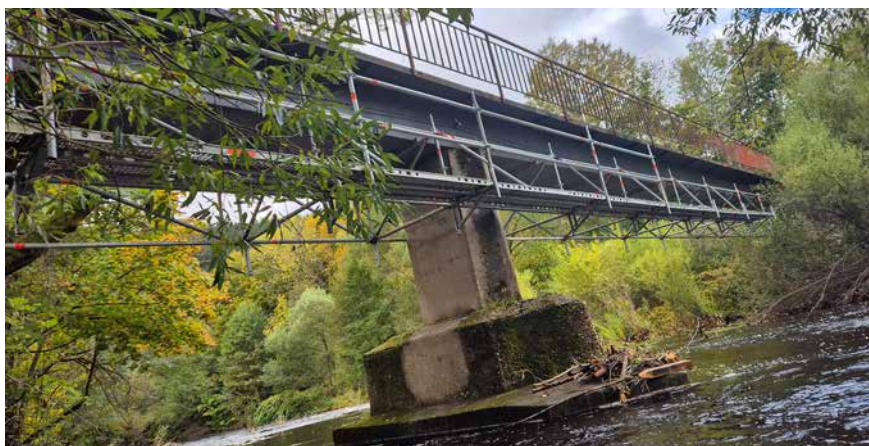
Jizeru za garážemi překoná vodovod zavěšený na mostku a na lávce. Aby bylo možné zaizolované potrubí k lávce uchytit, bylo u ní postaveno lešení s montážní lávkou.
