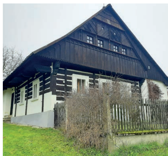
Lomenice chalupy čp. 232 nese v prostředním patře pro náš kraj typickou tzv. kočičí procházku. Ploché kuželky zde jakoby vynášejí horní patro lomenice a za nimi tím vzniká úzká cestička – tak akorát pro kočku.
