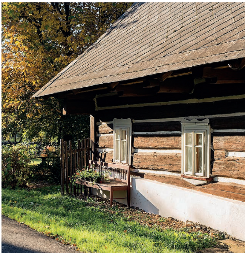
Skvostná chalupa U Jirů (čp. 219), která hostila i školu i hospodu (dobrá kombinace) a která je roubena z nesterjné silných a nadto již notné sesedlých trámů – pohlazení pro oko! Na snímku si povšimneme i pěkných šambrán kolem oken.
