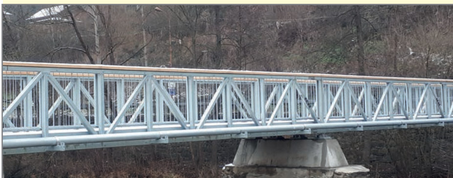
Lávka přes Jizeru před a po rekonstrukci.
