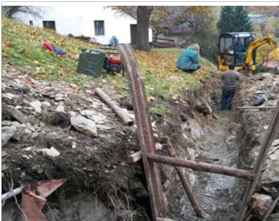
Při pokládání vodovodního řadu na Novotném kopci se museli dělníci poprat i se skálou - v levém dolním rohu vidíte, že Telecom skálu před lety neřešil (hloubka uložení 10 cm).
