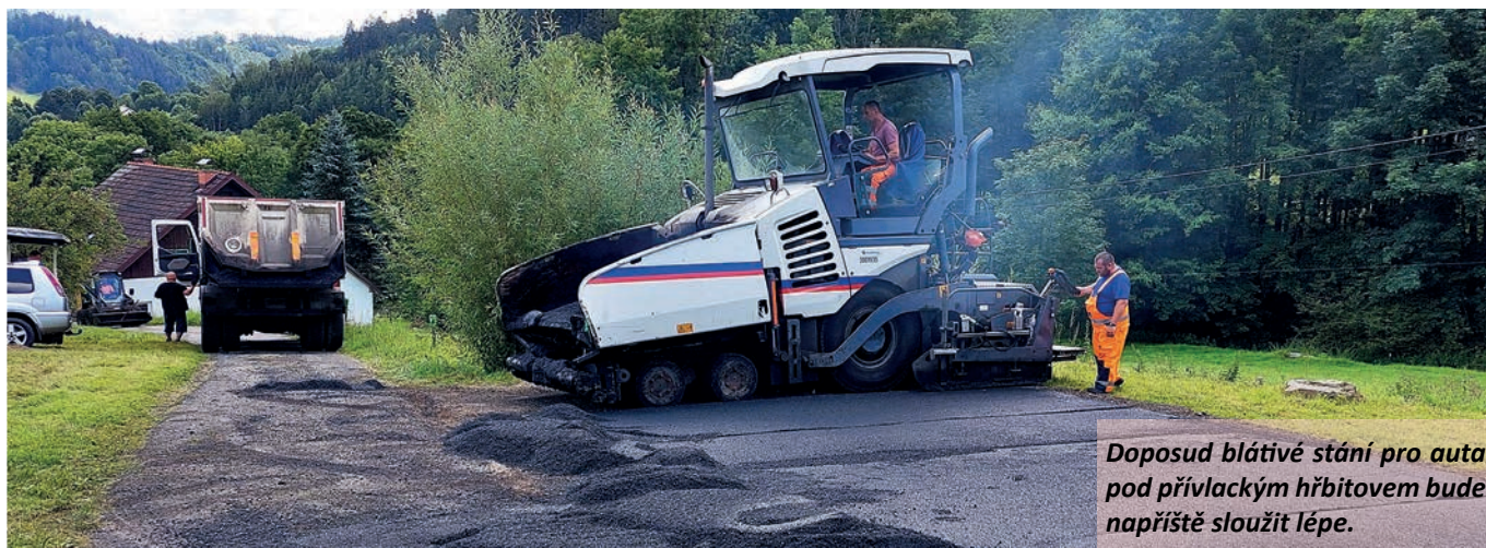
Prudká přívlacká cesta od kolejí k soše sv. Jana Nepomuckého se dočkala stabilnějšího kabátu.
