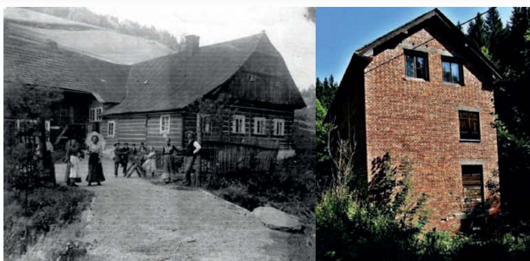
Zgruntu provedená přestavba mlýnu na Vejpalickém potoce na elektrárnu.
