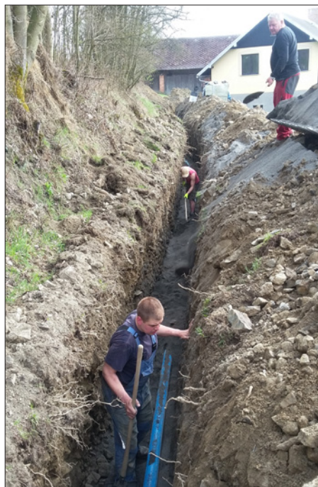
Zásyp potrubí (ve výkopu pan Hamáček a pan Dobiáš, nad nimi pan Šír)
