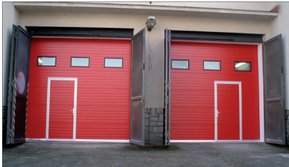
Na hasičské zbrojnici došlo k výměně plechových vrat za 2 ks sekčních vrat se stropním pohonem.
