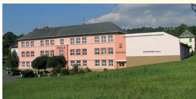
Školní budova po výměně oken a zateplení fasády – rok 2011.
