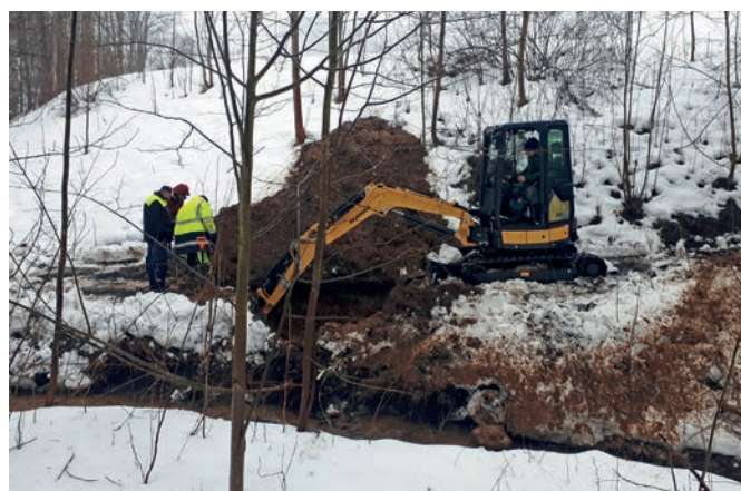
Se svým bagrem přispěchal pan Radomír Šír, s vyhledáním a opravou poruchy pomohli i zaměstnanci firmy KRVAK.
