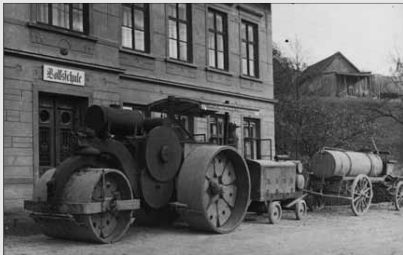
Stavba silnice v roce 1907.
