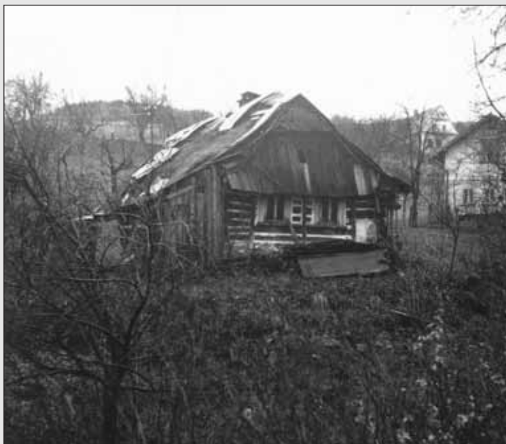
„U Kavanců“ – dnes požární nádrž.
