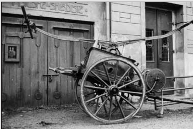
Hasičská zbrojnice v expozitūře.
