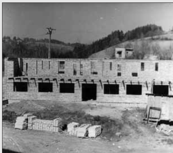
Stavba mateřské školy – 1980.
