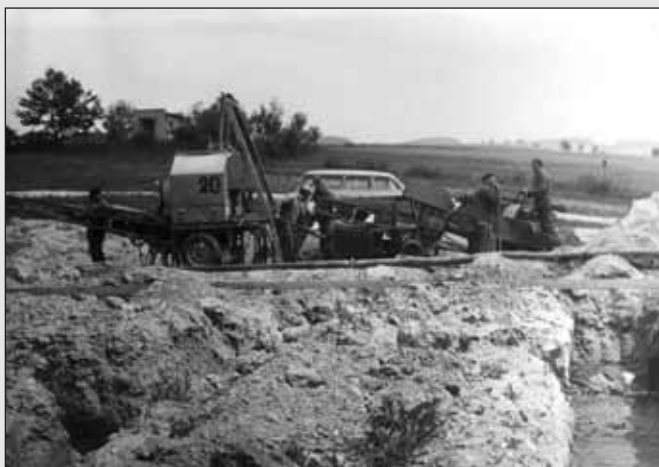
Stavba vodovodu v 60. letech.
